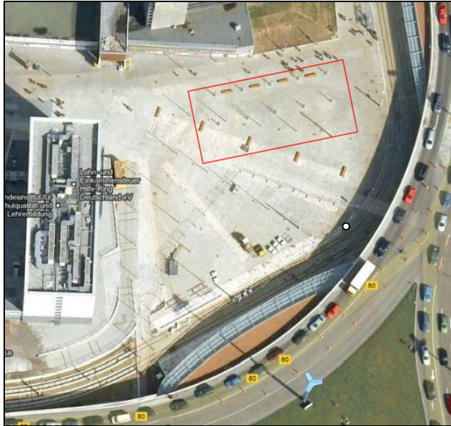
Foto 2: Der Vorplatz am Haus des Lehrers am Riebeckplatz (kurz vor Abschluss der Bauarbeiten). Die beiden Baumreihen mit je 5 Bäumen im nördlichen Bereich sind schon gepflanzt, fallen aber augenscheinlich nicht ins Gewicht (rot umrandet). Bis die Bäume ein Kronenvolumen aufgebaut haben, was den von Altbäumen im Ansatz vergleichbar wäre braucht es noch ca. 20 Jahre. Auf dem neuen Stadtplatzes am Steintor sollen stadteinwärts nach dem Brunnen ebenfalls 9 Bäume in gleicher Anordnung gepflanzt werden (Fehler: Referenz nicht gefunden, Foto 1). Ein jeder kann sich nun den neuen Platz am Steintor und die umliegende Fläche, die ebenfalls großflächig gepflastert werden soll vorstellen. Deshalb der Appell an die Stadtplanung: Setzen Sie sich für jeden Altbaum des Steintorparcs ein und loten Sie die Planung auf das Machbare aus.
