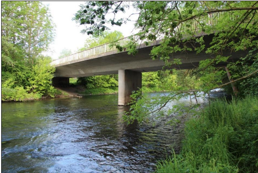
Abbildung 2: Werra oberstrom der Brücke, Blick in Fließrichtung (Aufnahme 24.05.2023)
